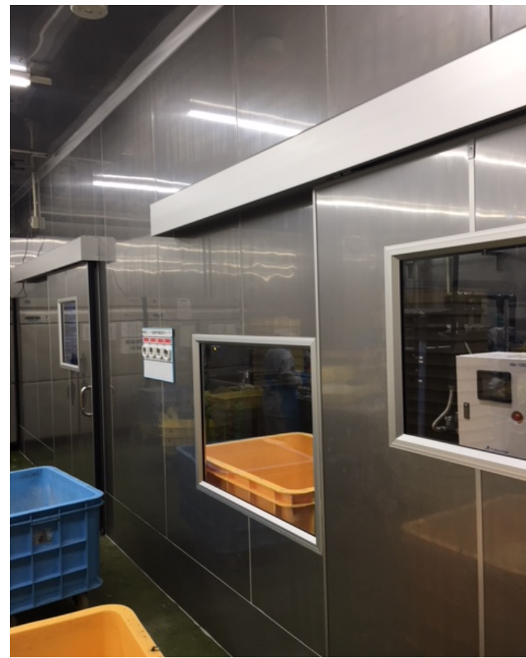
島根県JA関連施設 内壁パネル
