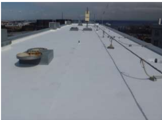
I社 様 屋上アスファルト
