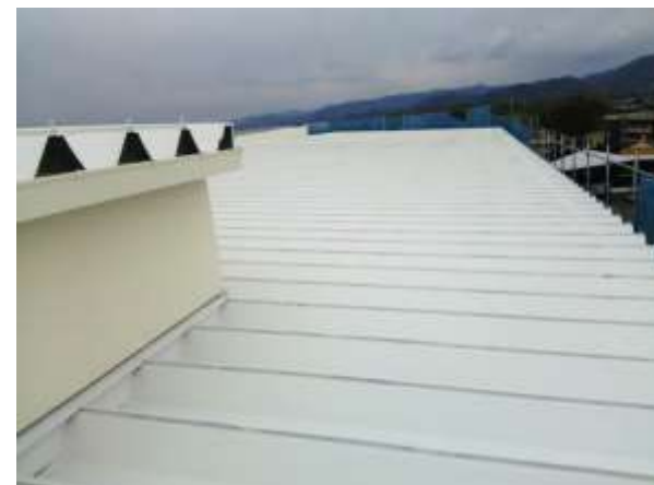
F社 様 屋上折板屋根
