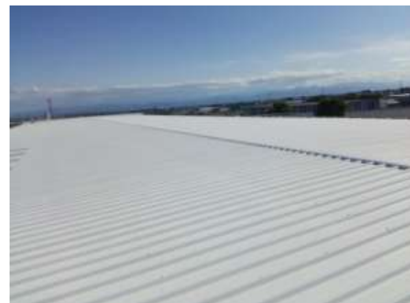
K社 様 屋上折板屋根
