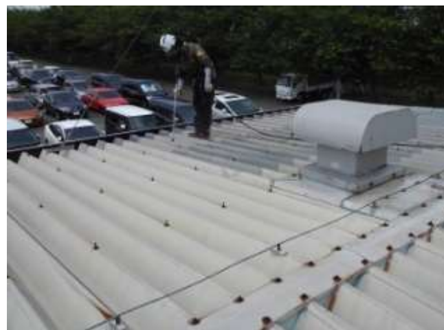
Y社 様 危険物倉庫屋根
